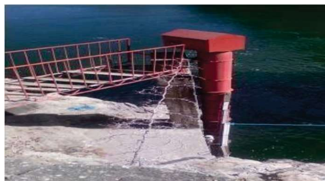
Figura 8. Estación hidrométrica del puente Kunyay en el Río Apurímac (Km 100 Carretera Cusco-Abancay)
