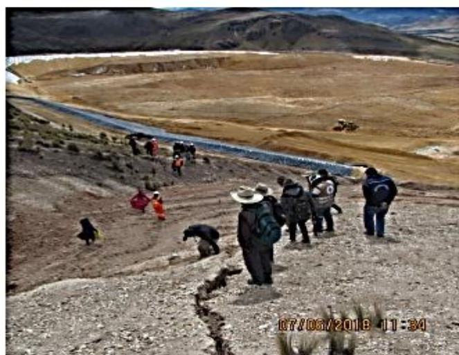
Fig. 3. Rajadura de pad de lixiviación- Unidad Minera Utunsa, a falta de estudios de ingeniería.
