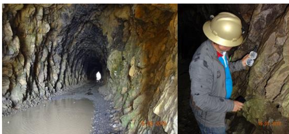
Figura 1. En la imagen de la izquierda se muestra el Túnel II en toda su longitud, y en la imagen de la derecha se está realizando la medición de mapeo geomecánico de las discontinuidades.
